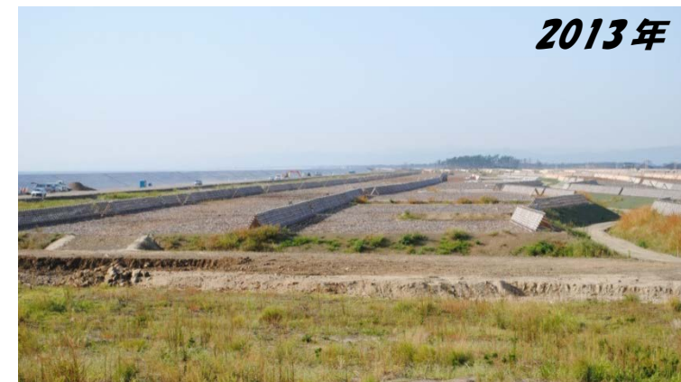
国の公共事業により高さ7mの防潮堤が造成され、かつて海岸林のあった場所には3mの盛土がされた。仕切りのように見えるのは東西双方からの強風を防ぐ防風柵 (2013年9月18日撮影)
